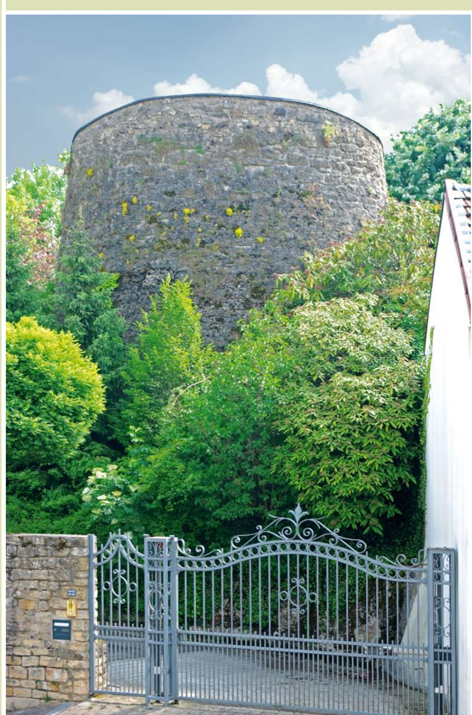
Vestiges d'une tour de l'ancien château
