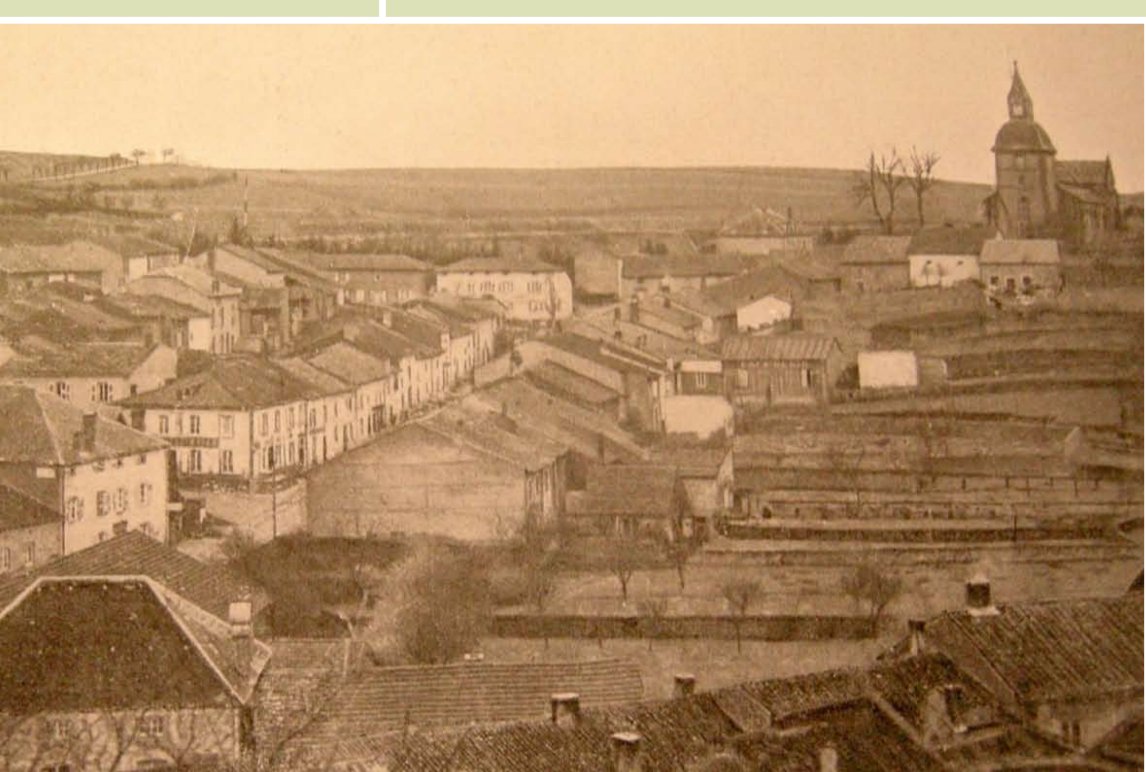
Vue d'ensemble en 1909 (Archives Municipales de Thionville)
